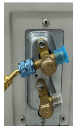
4. Connecter le tuyau du collecteur
