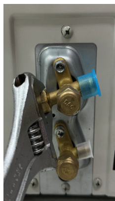
3. Retirer l' écrou
