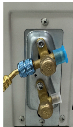
4. Connecter le tuyau du collecteur
