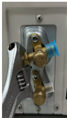
3. Retirer l' écrou
